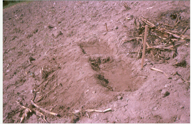
Figura 33. Zanjas de infiltración
